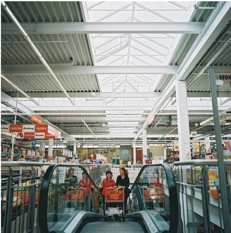
Bild 9: Beleuchtung mit Lichtband
