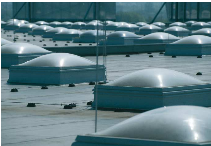
Bild 8: Lichtkuppeln zur Beleuchtung einer Halle.
