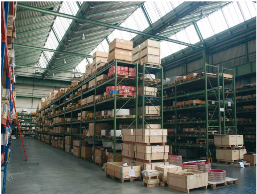
Bild 11: Nutzung des Tageslichts in einem Lager durch ein Sheddach.
