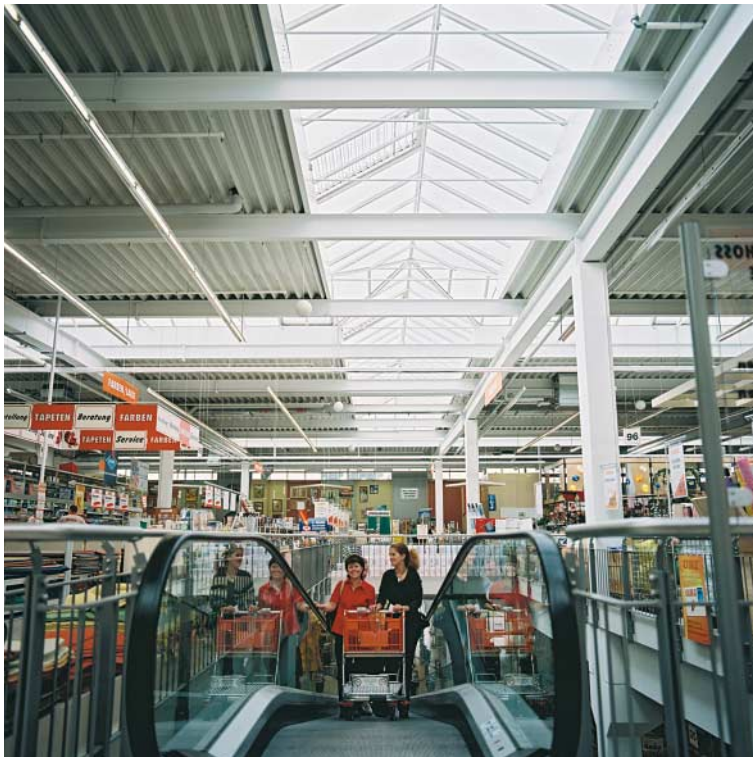
Bild 9: Beleuchtung mit Lichtband
