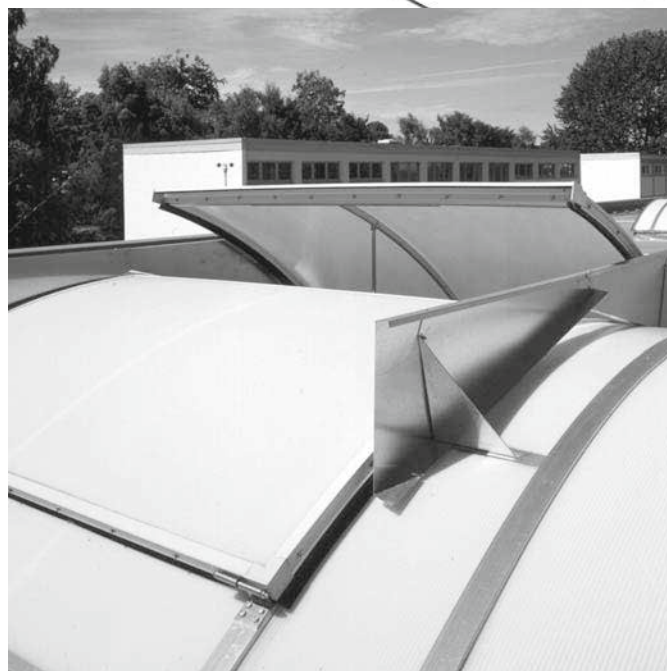
Abb. 14/15: Weniger witterungs- abhängige Lüftung
