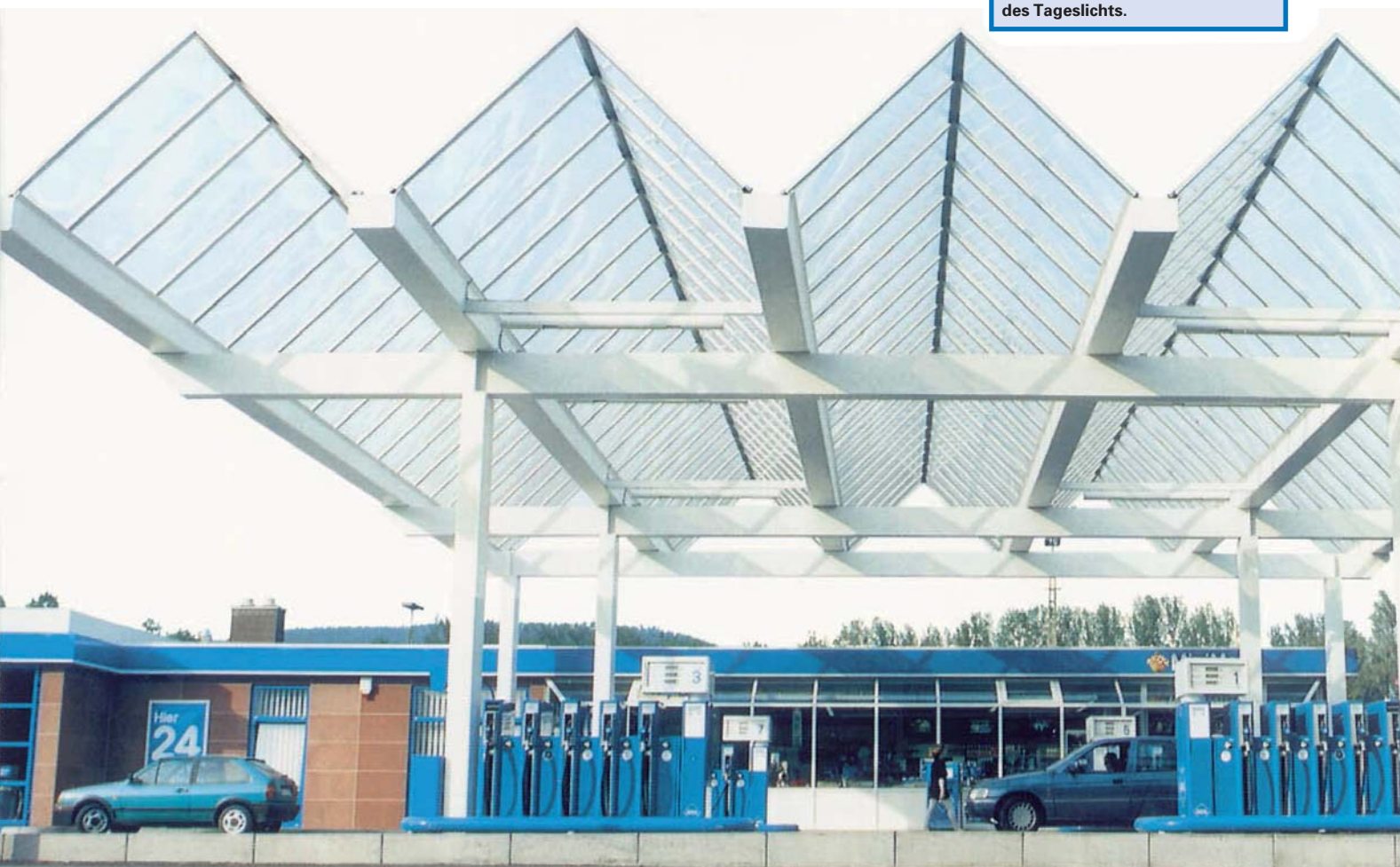
Bei Tankstellen werden Lichtbänder häufig als Überdachung eingesetzt. Die Vorteile liegen auf der Hand: Schutz vor Witterungseinflüssen bei gleichzeitiger Nutzung des Tageslichts.
