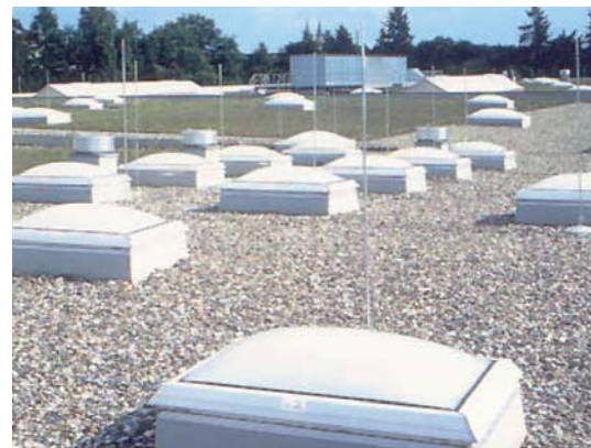
Lichtkuppeln ermöglichen nicht nur die Beleuchtung mit natürlichem Tageslicht. Sie leisten gleichzeitig einen Beitrag zur Raumlüftung und zum Rauchabzug im Brandfall.
