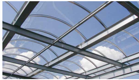
Die Lichtflächen von Lichtkuppeln und Lichtbändern werden meist aus thermoplastischen Kunststoffen hergestellt, deren Schmelztemperatur unter 300 °C liegt.
