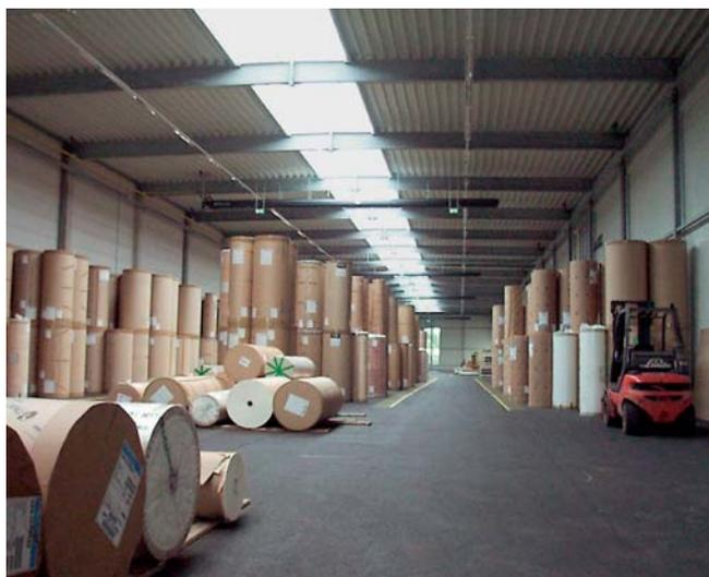
Ein gewölbtes Dachoberlichtband aus opal eingefärbten Polycarbonat-Stegdoppelplatten sorgt für gute Ausleuchtung des Verkehrswegs und ausreichende Beleuchtung der Lagerflächen.
