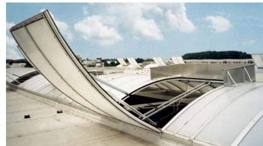
Rauch- und Wärmeabzugsgeräte und Lüftungseinrichtungen können ohne weiteren Nachweis als Wärmeabzüge berücksichtigt werden.
