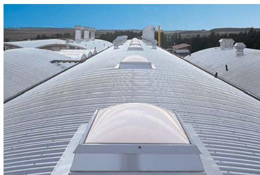
Dachoberlichter aus thermoplastischen Kunststoffen eignen sich aufgrund ihrer Schmelzeigenschaften gut als Wärmeabzüge.
