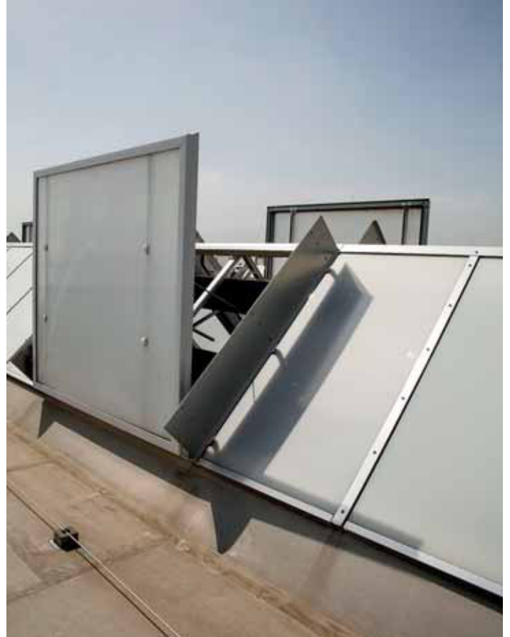
Wenn sich die Dachoberlichter auch zum Lüften öffnen, bringen sie einen Mehrfachnutzen: Tageslicht, Sicherheit im Brandschutz und die Lüftungsmöglichkeit.
