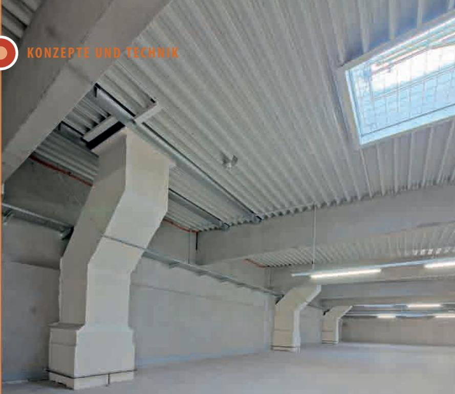
Abb. 5: L 90-Abluftkanäle
