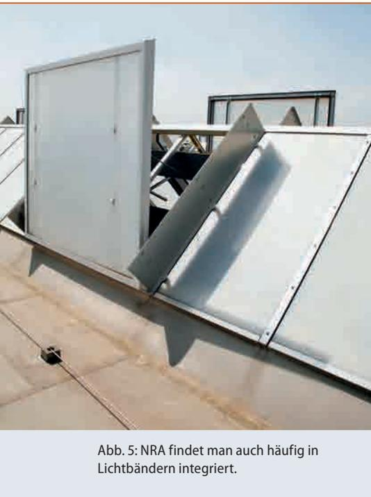
Abb. 5: NRA findet man auch häufig in Lichtbändern integriert.
