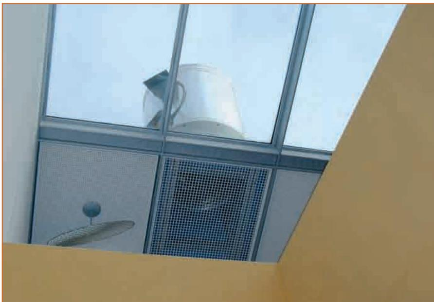
Abb. 3: Direktabsaugung mittels eines Entrauchungs-Dachventilators
