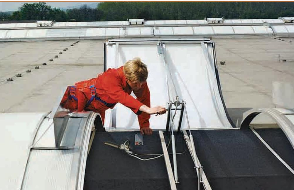
Abb. 1: Durchführung von Wartungsarbeiten an einer RWA-Lichtbandklappe
