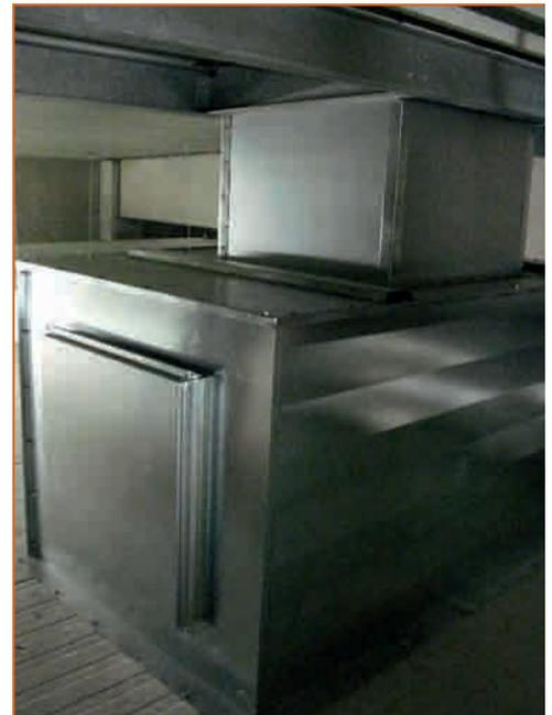
Abb. 4: Revisionsöffnung über der beheizten Kühlhausklappe
