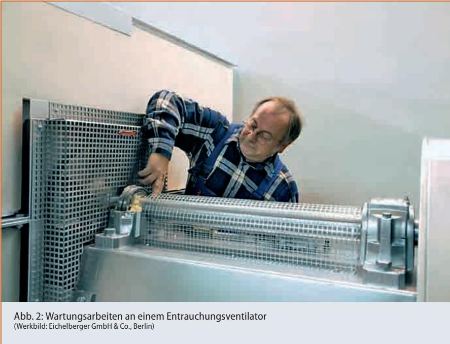
Abb. 2: Wartungsarbeiten an einem Entrauchungsventilator
