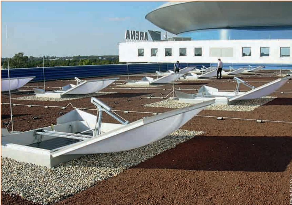
Abb. 1: NRA sind häufig in Lichtkuppeln eingebaut.
