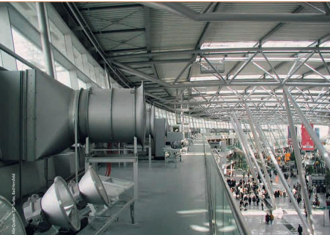
Abb. 1: Axiale Entrauchungsventilatoren zur Direktabsaugung auf dem Balkon des modernen neuen Terminals am Düsseldorfer Flughafen
