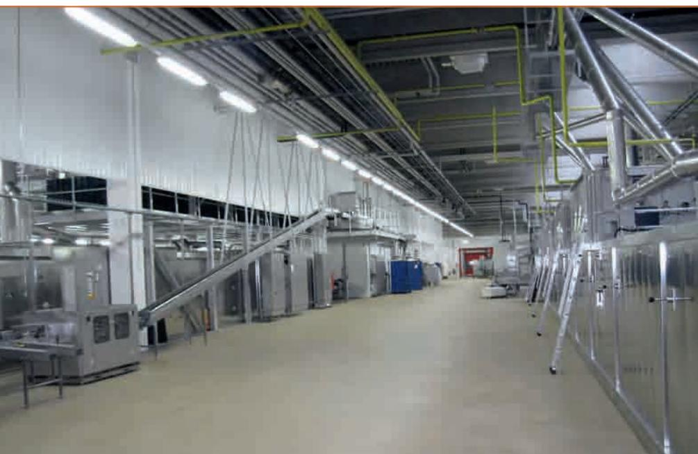
Abb. 2: Am linken Bildrand ist die Rauchschräge in der Produktion zu sehen, Unterkante 4 m.
