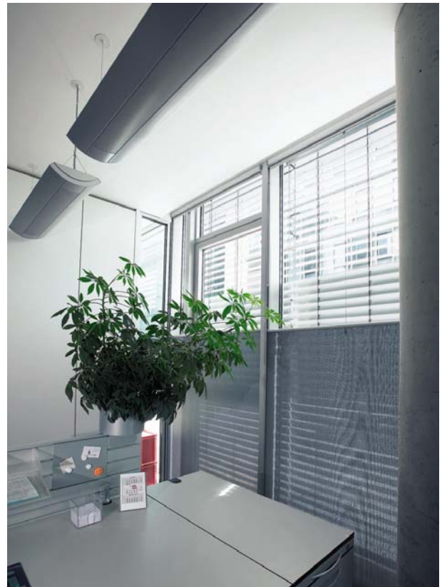
Bild 30: Zweiteilige Lamelle, der obere Bereich leitet Licht in den Innenraum
