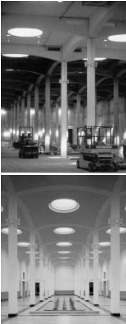
Bild A.4 Rohbau und Ausbau einer Oberlichthalle /A.59/
