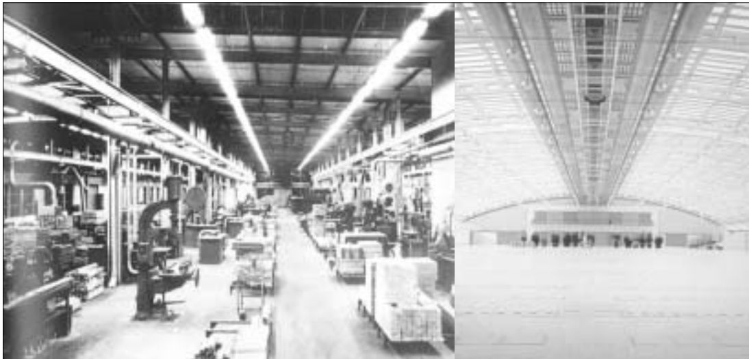
Bild E.26 Erscheinungsbilder von zwei Hallen Links: Eine übliche Industriehalle unter künstlicher Beleuchtung mit Lichtbändern Rechts: Eine natürlich beleuchtete Halle mit großen leuchtenden Flächen /E.43/
