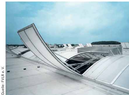
In Dachoberlichtern integrierte Rauchabzugsgeräte erfüllen die Anforderungen der Brandschutzbehörden.
