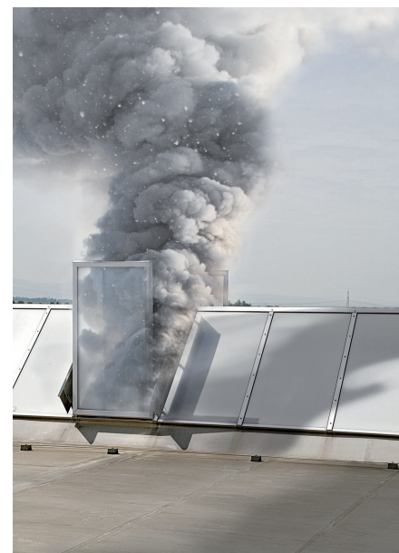
Bild 4 Rauch- und Wärmeabzugsgeräte leiten im Brandfall Rauchgase und Brandhitze gezielt aus dem Gebäude nach außen ab. Bild: www.fvfr.de
