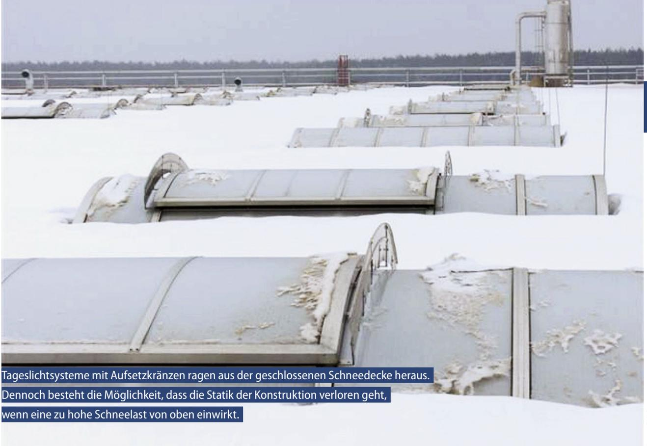
Tageslichtsysteme mit Aufsetzkränzen ragen aus der geschlossenen Schneedecke heraus. Dennoch besteht die Möglichkeit, dass die Statik der Konstruktion verloren geht, wenn eine zu hohe Schneelast von oben einwirkt.
