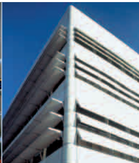
Individuell verstellbare Lamellen gewährleisten eine gute Wärmereflexion und fein dosierte Lichtdurchlässigkeit.
