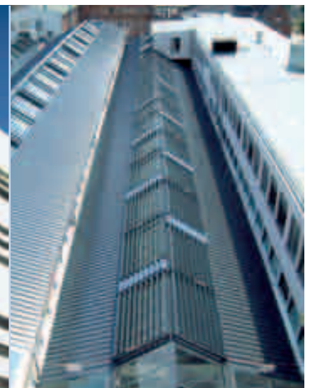
Wirtschaftlich und effektiv: Jalousien als Sonnenschutz für Lichtkuppeln. Sie verhindern eine zu starke Aufheizung.
