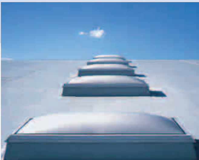
An einem wolkenlosen Sommertag beträgt die Beleuchtungsstärke im Freien rund 100.000 Lux. Lichtkuppeln bringen das Tageslicht direkt in das Gebäude.
