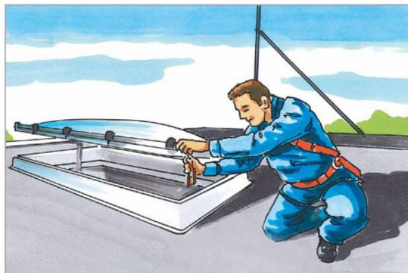
Für die klassischen Lichtkuppeln und (gewölbten) Lichtbänder, wie sie von den Mitgliedern des FVLR vertrieben werden, sind eine Reihe von Systemen für die Durchsturzsicherheit entwickelt worden, die sich nachhaltig wirksam und funktional in das Lichtelement oder den Aufsetzkranz integrieren lassen.
