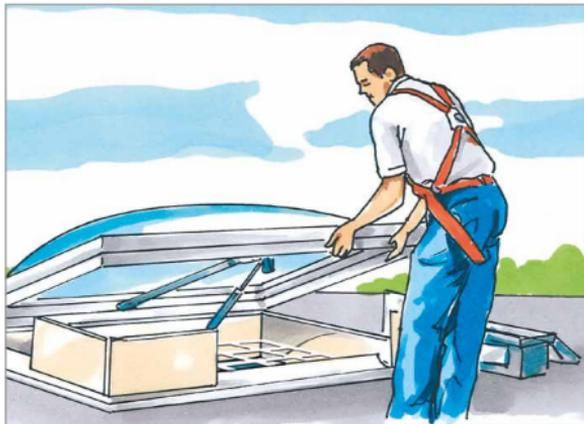
Individuelle Maßnahmen wie der Anseilschutz dienen der Sicherung einer einzelnen Person. Sie sind lediglich zulässig, wenn kollektive Schutzmaßnahmen aus technischen Gründen nicht möglich sind, und erfordern geeignete Anschlagein-
