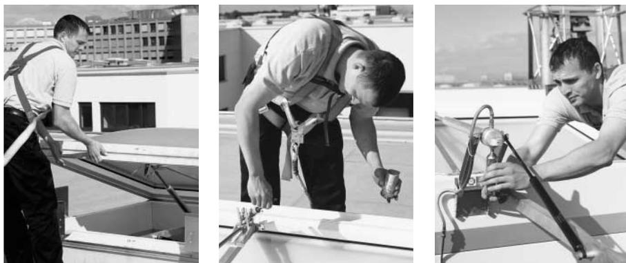
■ Jede RWA sollte mindestens einmal im Jahr gewartet werden. Nur dann ist gewährleistet, dass sie im Brandfall auch einwandfrei funktioniert. Dabei sollte besonders aufmerksam der Zustand der Öffnungszylinder bzw. Scharniere kontrolliert werden, weil Stäube und Produktionsdämpfe sie schnell schwergängig und sogar funktionsunfähig machen.
