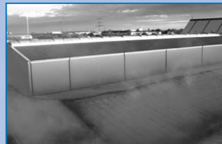
Stahltrapezblech ist weitgehend hitzebeständig, die tragenden Bauteile verlieren bei einem Brand schnell die Tragfestigkeit.
