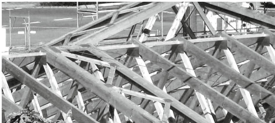
Typische Supermarkt-Dachkonstruktion mit Nagelplattenbindern.
