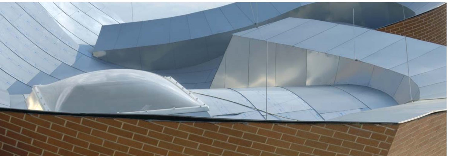
Lichtkuppeln krönen die überdimensionierten Lichtschächte, über die Tageslicht in die fensterlosen Räume gelangt.
