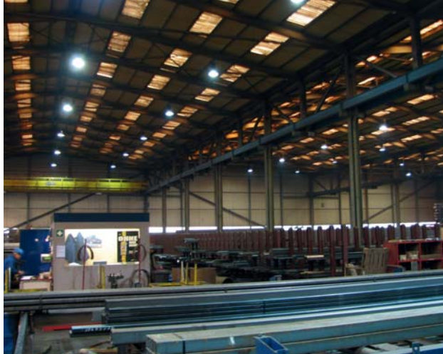
Tageslichteinfall vor der Sanierung ...
